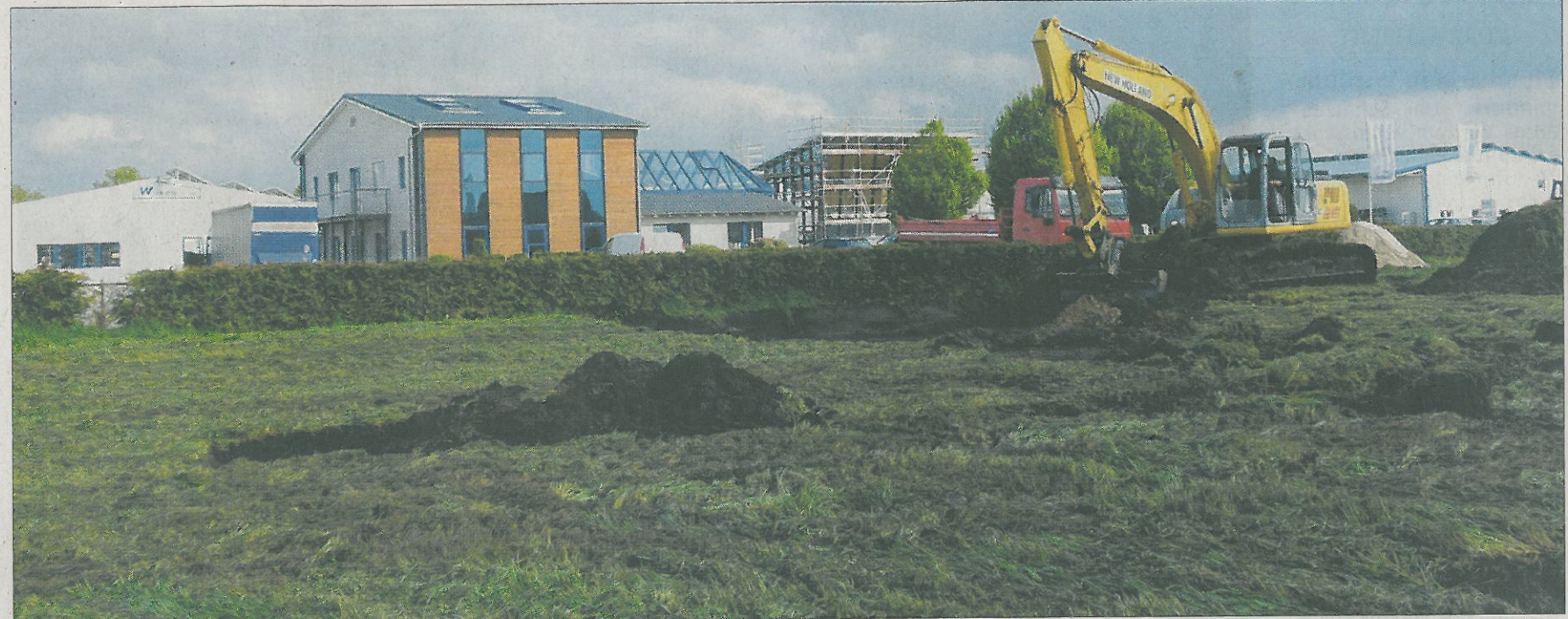
Die ersten Bagger stehen schon. Die Wiesmoorer Wilken GmbH erweitert ihren Firmensitz.
