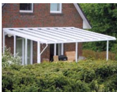
Pultdach mit vorgehängter Rinne
